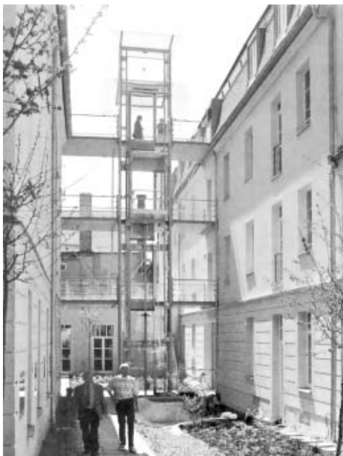
DIN 18024 Teil 2/TRA 1300: der barrierefreie Aufzug als außen angehängte Einheit, z.B. zur gleichzeitigen Erschließung von zwei Gebäuden von der Gasse
