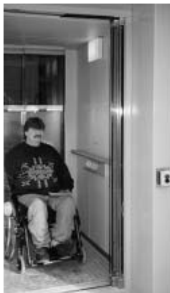
Im Bild: Beispiel einer barrierefreien Aufzugskabine mit waagrechttem Tableau, Spiegel etc. Quelle: USTO-Aufzüge
