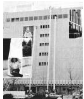
Diese Rettungsruutschen, nutzbar bis zum 12. bis 14. O.G., in senkrechter oder schräger Anordnung, sind die zur Zeit möglichen, für alle anwendbaren Evakuierungswege. Im Schlauch erfolgt eine zwingende Fallbremsung und verhindert ein Aufeinanderstoßen.
