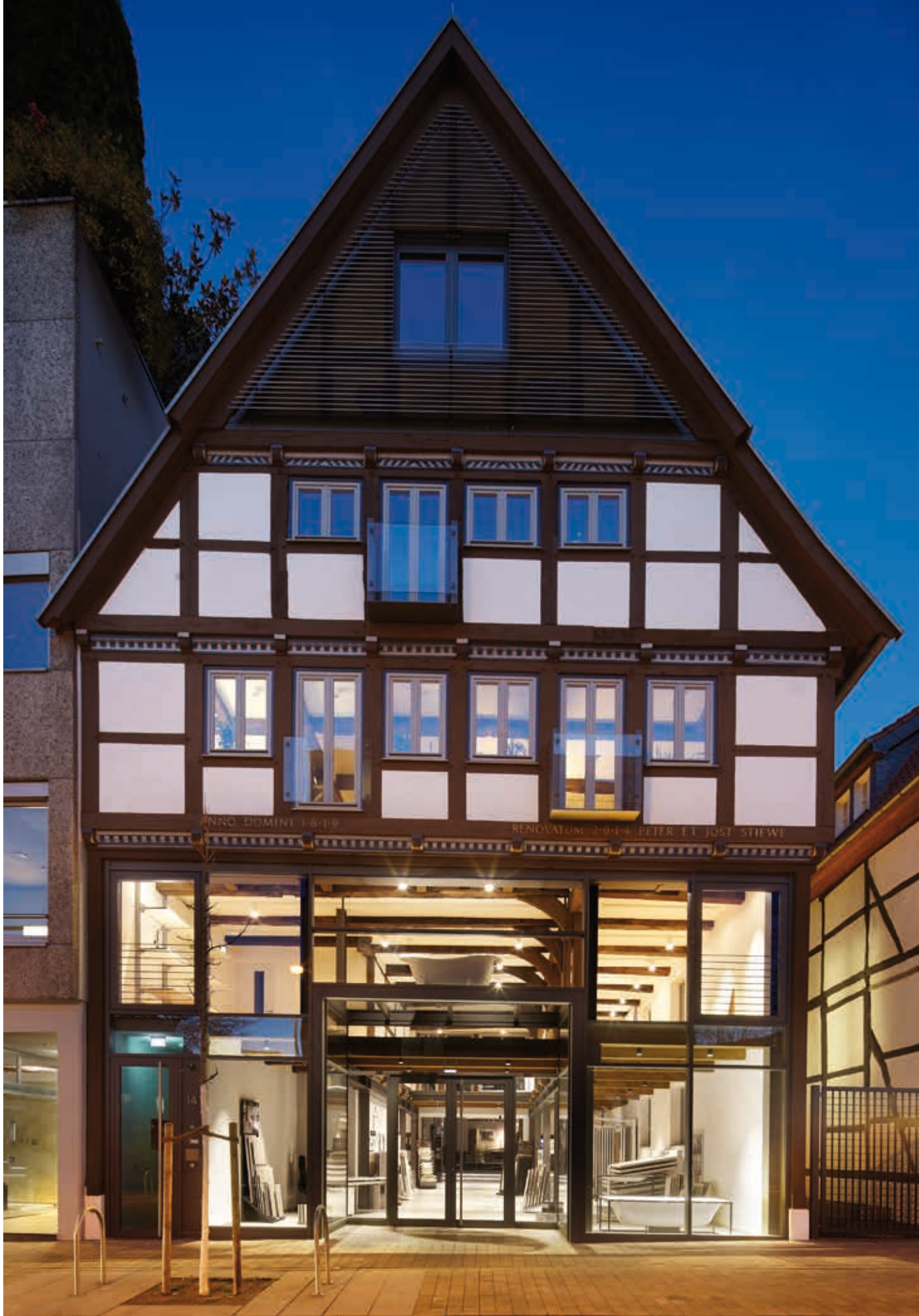
Mit der Sanierung des Hauses „Stüwe“ von 1619 ist es Architekt Peter Völse (Borchen) gelungen, im Stadtbild von Paderborn historische Fachwerkarchitektur mit moderner Formsprache zu verbinden. Im Untergeschoss wurde die Ständerwerkkfassade voll verglast. So sind moderne und lichtdurchflutete Räume für eine Badausstellung entstanden.
