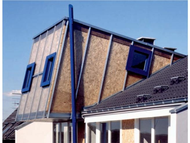
„Dach-auf-Bau“ (Köln): Aufstockung eines Satteldachs durch einen schräg gestellten Quader (Architektur: UTE PIROETH ARCHITEKTUR)
