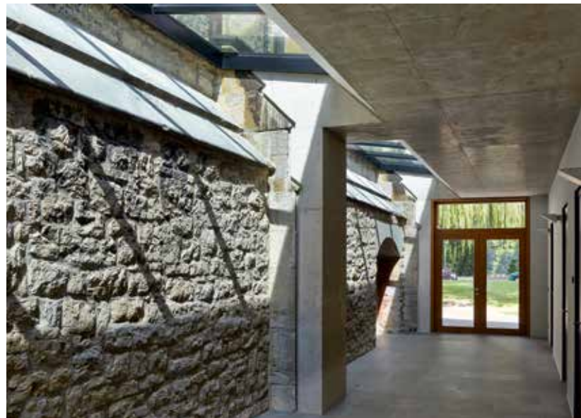
Anschluss des Neubaus an den Bestand
