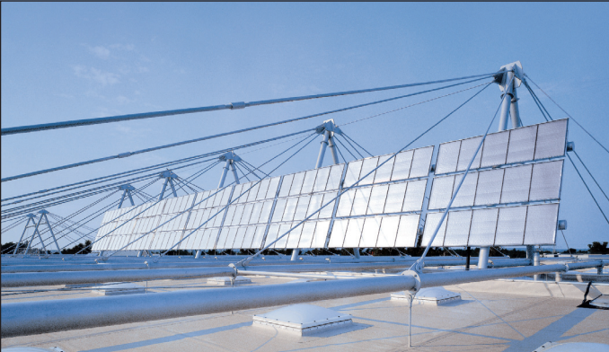
Nullemissionsfabrik Solvis in Braunschweig (Architekten: Banz+Riecks Architekten, Foto: Christian Richters)
