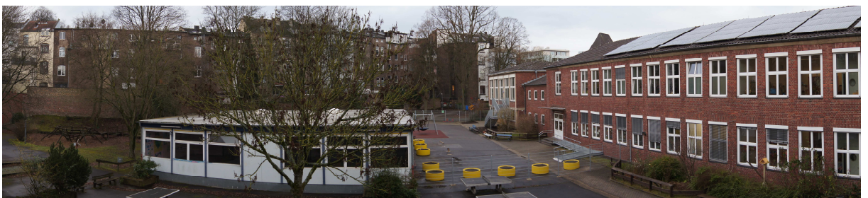
Bild 6 – Bestandsgebäude und Schulhof - überplanbar
