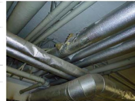
Beschädigte Wärmedämmung an Heizungsleitung. Technikzentrale, A-Trakt
