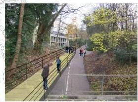
Stahlrampenkonstruktion, auf die Brücke aufgelegt. Kostenaufwendigere Konstruktion, räumlich schwing integrierbar
