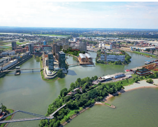
Mit dem Pier One, einem Stelzenbau auf dem Wasser, entstehen zugleich vier neue Brücken im Düsseldorfer Hafen.
