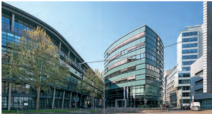
Foto: © Ingo Lammert / Architektenkammer NRW
