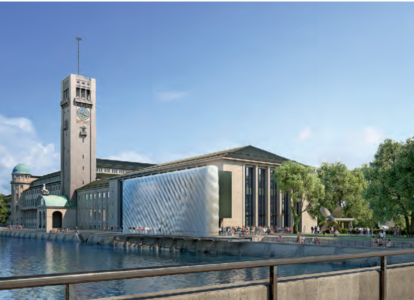
Anwendungsbeispiel „Multifunktionale 3D-gedruckte Fassade“, Deutsches Museum München. Fassadenentwurf: 3F Studio – Mungenast Tessin Morroni
