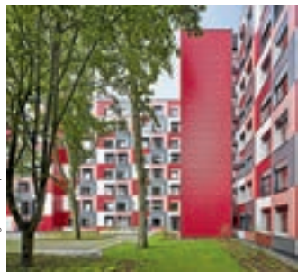
Energetisch saniert: Studentenwohnheim in Essen vom Contor Müller Schlüter
