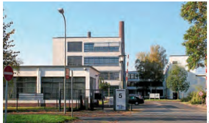
Gebäudeensemble „VerSeidAG“ von Mies van der Rohe in Krefeld
